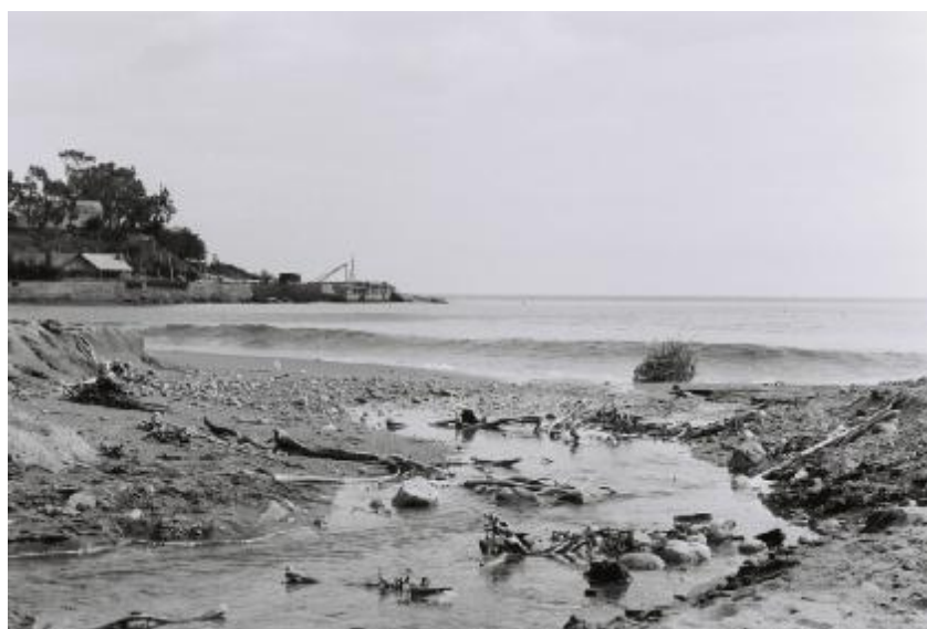
Lo que dejó del muelle el temporal, visto desde el desagüe de la Quebrada del francés
