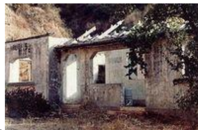
Lo que queda de la Estación Palos Quemados
