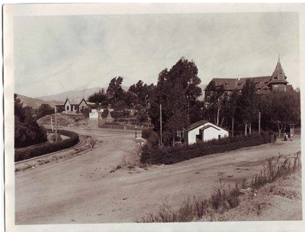
La planta eléctrica a petróleo que producía el alumbrado de Papudo
